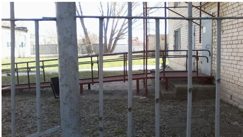
Вход сбоку в 3 корпус ул.Ленина,70
