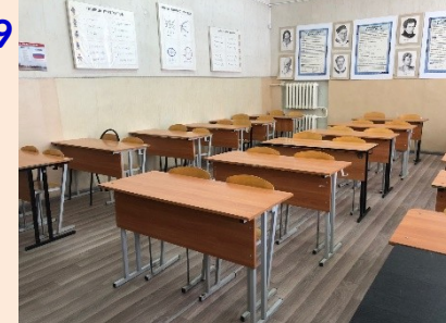
Замена линолеума - Мурысева, 61
